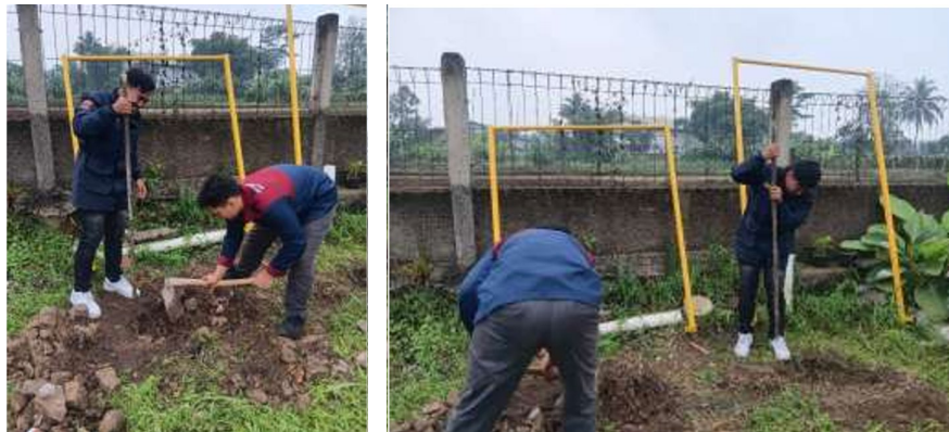
Gambar 2. Proses persiapan pondasi pemasangan pull-up bar outdoor
