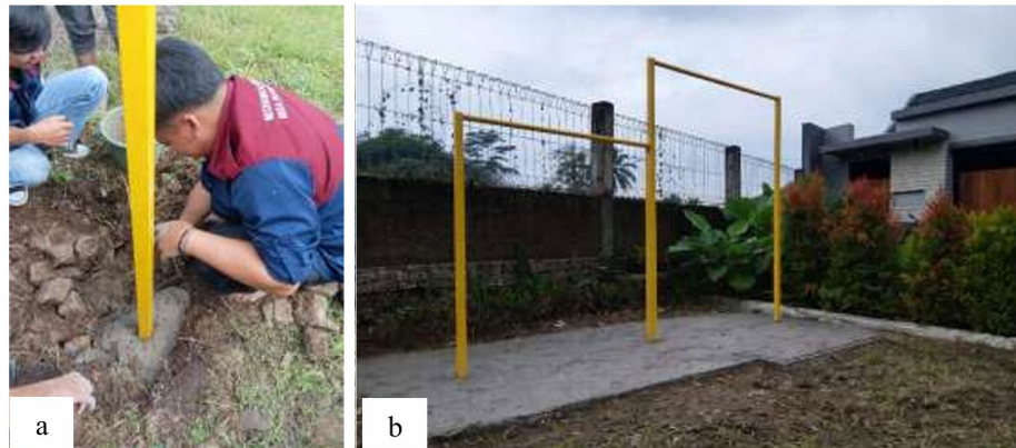
Gambar 4. (a) Proses pengecoran beton pada bagian dalam pondasi tiang pull-up bar outdoor ; (b) Proses pelapisan mortas pada bagian atas pondasi pull-up bar outdoor untuk perapihan dan perlindungan struktur.
