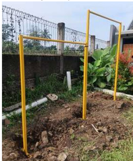
Gambar 3. Proses peletakan dan penyesuaian posisi pull-up bar outdoor pada lubang pondasi
